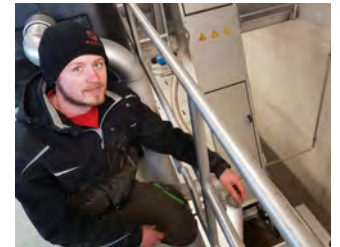
Unser Klärwärter Alexander Schärfinger ist bestens für den Betrieb der neu errichteten Kläranlage geschult.
